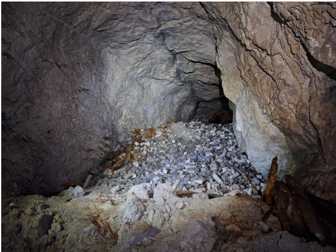
Részlegesen tömedékelt várat az Antoni-akna felsőbb szintjeinek egyikén Bleibergben
